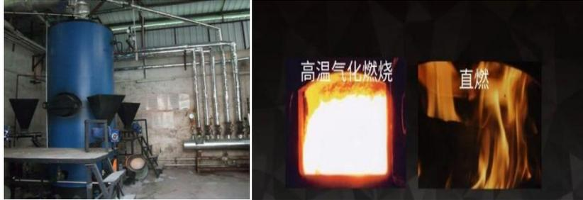
图 1 生物质高温热解气化燃烧装置
